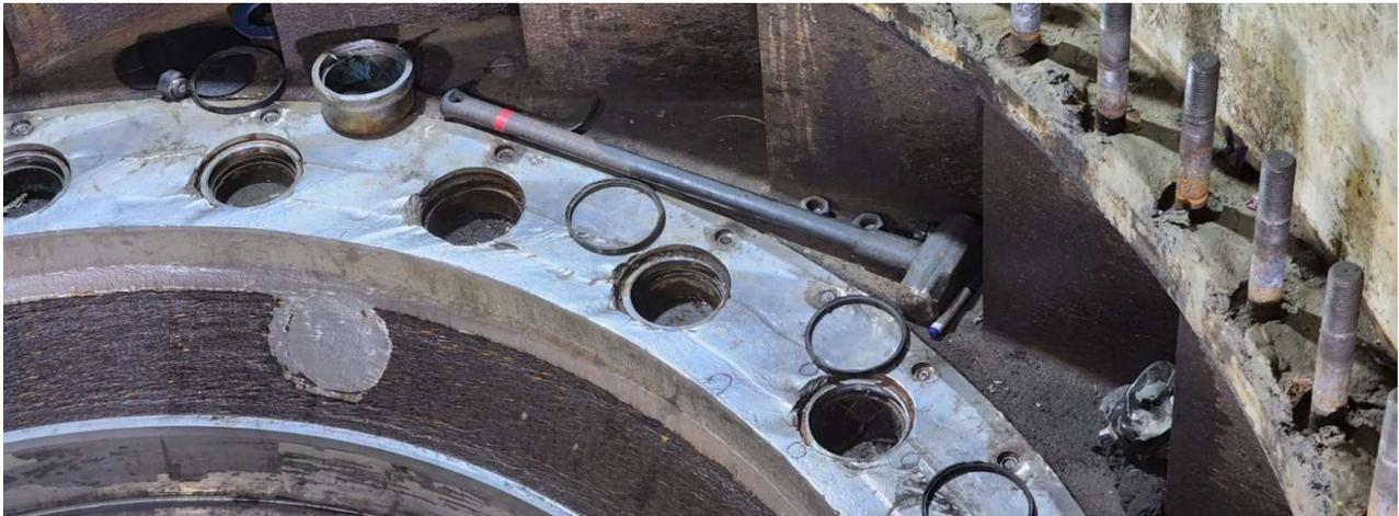
Antigua placa de desgaste, toda dañada por los efectos del agua, antes de sacar los pernos de anclaje de la placa.
